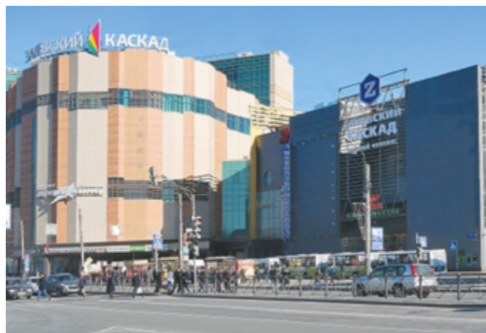
ТРК «Заневский Каскад», г. Санкт-Петербург
